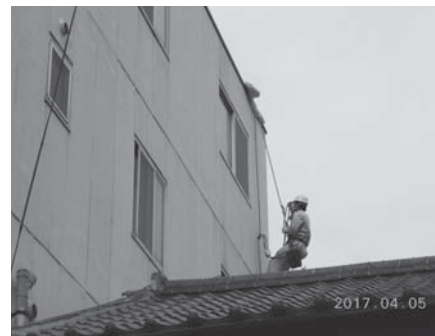
熊本地震後の屋根の補修工事
